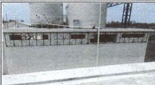
Foto 13: Accesorios de depósitos de agua y tubería.
