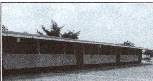
Foto 6: Pintura en muros y paredes
