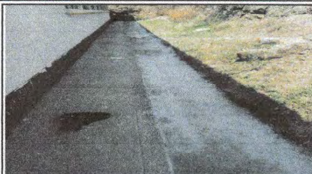
Foto 14: Cuneta de concreto
