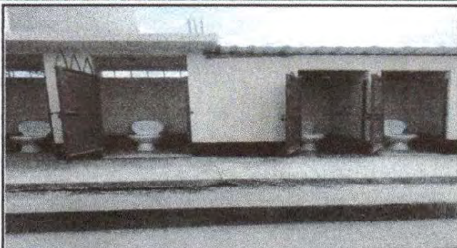
Foto1: Instalación de 5 sanitarios nuevos
