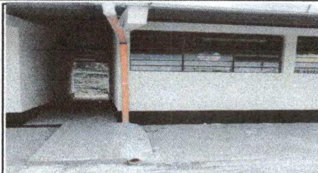
Foto 2: Bajadas de aguas pluviales
